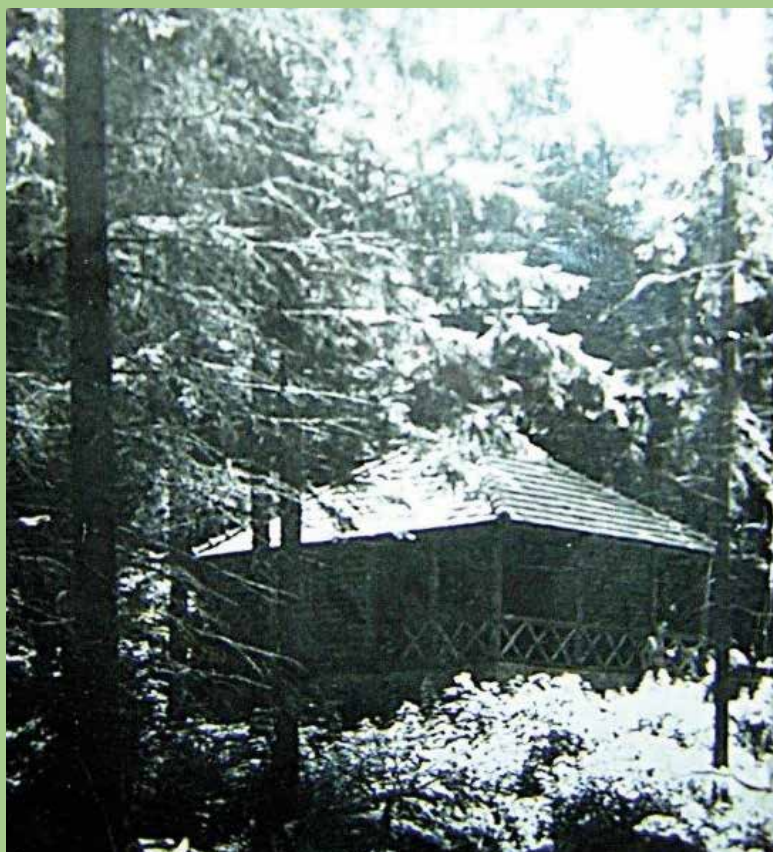
Döbrönte kiváló kiindulópontja számos bakonyi bakancsos túrának is. Kényelmes sétával elérhető például az Ödön-forrás, amely mellett évtizedekkel ezelőtt a képen szereplő rönkház bújta meg a sudár fák között. A vállalat tervei között már régóta szerepel az Ödön-forrasi rönkház felújítása.
