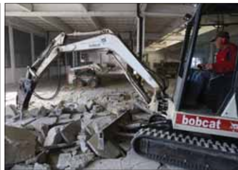
Elkezdődött a középrétegsor-beruházás. Bontják a csarnok padozatát
